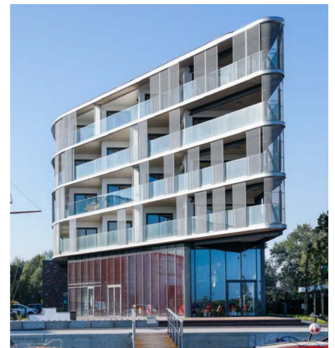
ClubHouse Szczecin, Polska Architekt: Orłowski, Szymański - Architekci Producent: Elastico Sp. z o.o.
